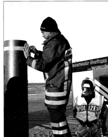
Bild oben: Anbringen des Reflektorstreifens.
